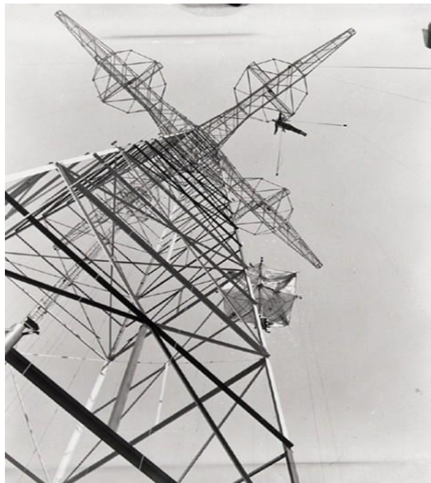
75 meter hoge trainingstoren op Fort Benning, Georgia, VS
